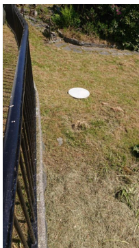
Eldre septiktank og stakekum skal fjernes.
